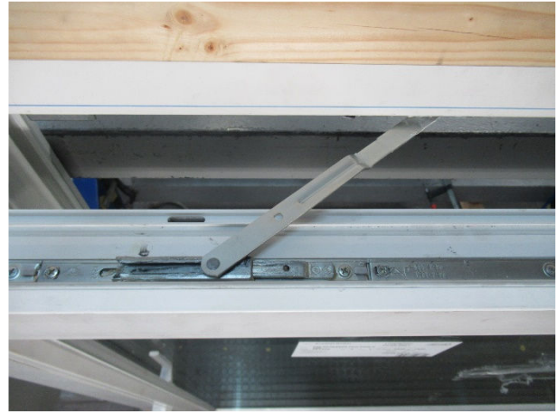
Bild 8 Zusatzschere, Falzansicht
