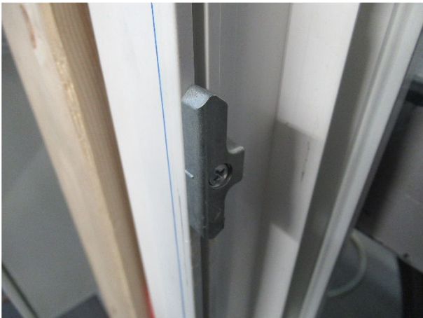
Bild 9 Verriegelungssituation Blendrahmen 1
