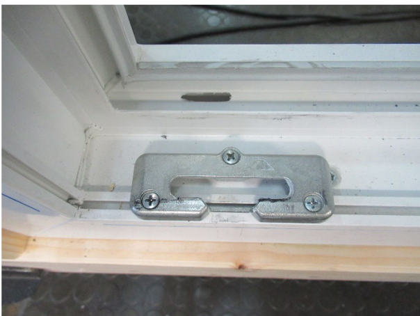
Bild 11 Verriegelungssituation Blendrahmen 2
