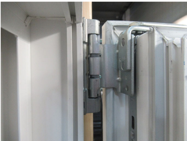
Bild 3 Scherenlager, Falzansicht Blendrahmen
