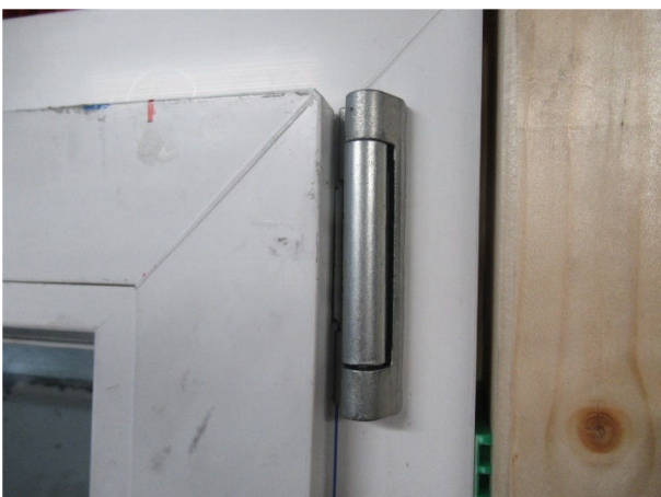
Bild 5 Scherenlager, Ansicht innen
